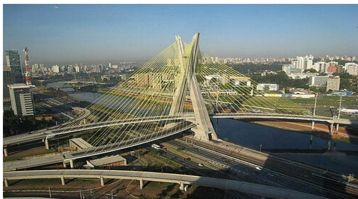
Рис. 2. Мостовое сооружение Мост Октавио Фриас де Оливейро
