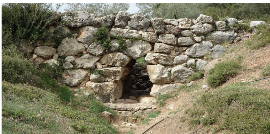
Рис. 1. Арочный мост Аркодико
