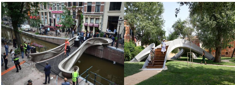
Рис. 3. Мостовое сооружение Striatus и мост в Амстердаме
