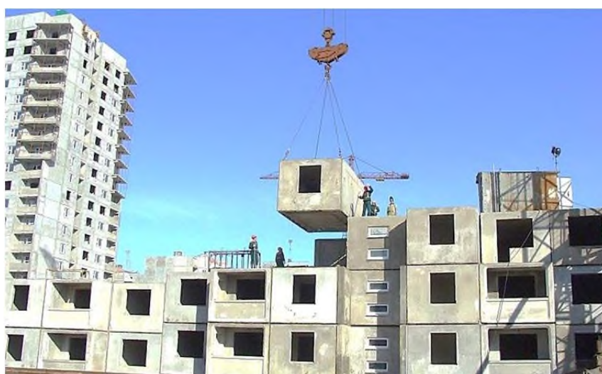
Рис. 4.1. Монтаж объемно-блочного жилого дома
