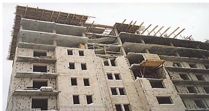
Рис. 3.1. Строительство монолитного здания в г. Минске
