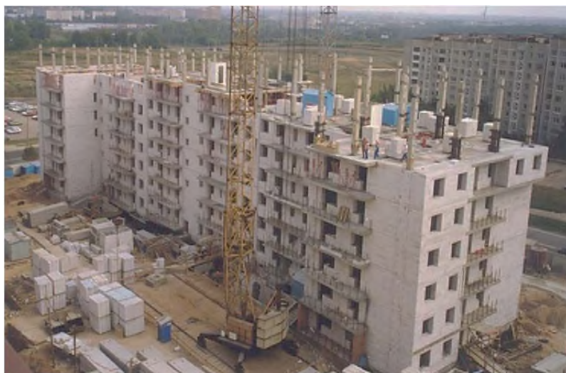
Рис. 3.4. Строительство сборно-монолитного жилого дома серии Б 1.020.1-7
