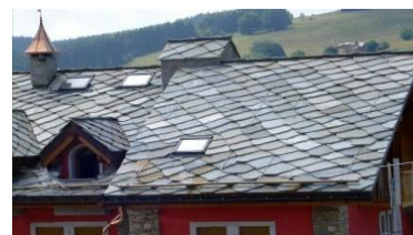
Рис. 2.2.76. Кровля из каменной плитки.
