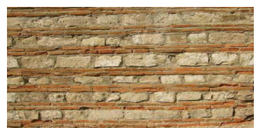
Рис.2.3.11 Кладка стены с использованием плимфы и природного камня
