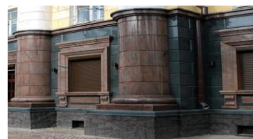
Рис. 2.2.74. Облицовка колонн и стены полированным гранитом
