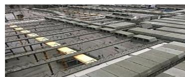
Рис.2.5.21. Плиты перекрытия по новой технологии
