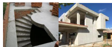
Рис.2.5.33. Монолитные элементы жилого дома
