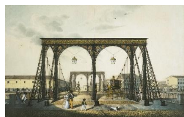
Рис.2.6.14. Пантелеймоновский мост в Петербурге
