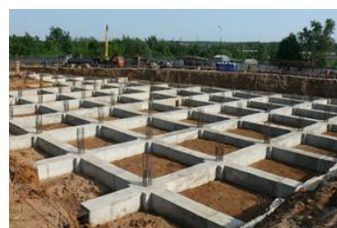
Рис.2.5.26. Раскладка ленточного фундамента
