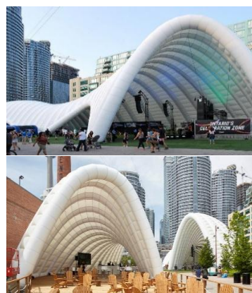
Рис.2.7.42. Пневмо-конструкция павильона зоны празднования в Онтарио, Торонто, Канада(2015г.), архитектор Харири Понтарини
