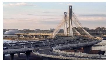
Рис.2.5.56. Мост через Корабельный фарватер Санкт- Петербург, Россия(2013— 2016гг.)
