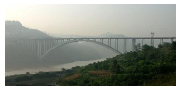
Рис.2.5.57. Арочный мост Ваньсянь мост через р. Янцзы в г. Чунцине, Китай,1997г.
