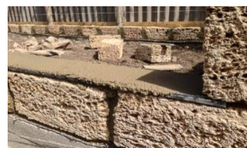
Рис. 2.2.71. Природный камень в кладке стены.
