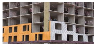
Рис.2.5.25. Монтаж стеновой панели
