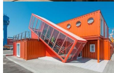
Рис.2.7.11. Дома контейнерного и передвижного типа.
