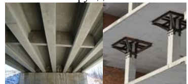
Рис.2.5.27.. Опоры в конструкции моста и междуэтажного перекрытия
