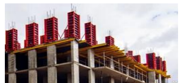
Рис.2.5.29. Возведение монолита с помощью переставной опалубки
