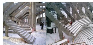
Рис.2.5.31. Конструкции лестничных маршей в монолитной конструкции стадиона
