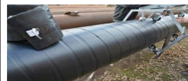
Рис.2.6.42. Битумно-полимерная изоляция труб
