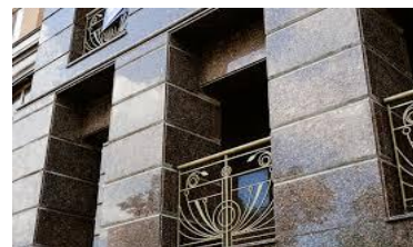
Рис. 2.2.72. Облицовка наружной стены полированным природным камнем
