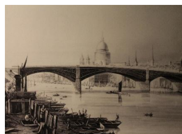
Рис.2.6.13. Саутверский чугунный мост через реку Темзу, Лондон
