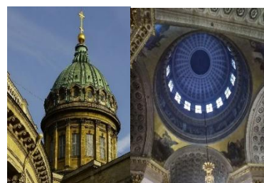
Рис.2.6.11. Купол Казанского собора в Санкт-Петербурге
