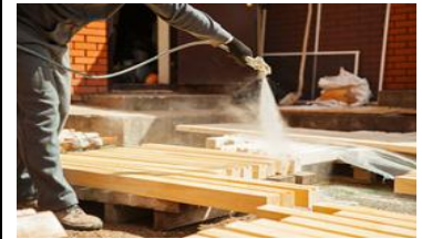
Рис.2.1.19. Защитная обработка древесины
