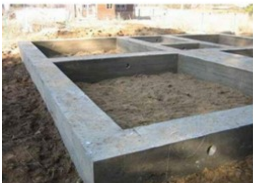
Пример монолитного фундамента
