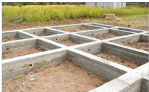
Пример ленточного фундамента
