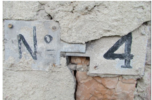
Рис. 7.15. Пластичный раздвижной маяк
