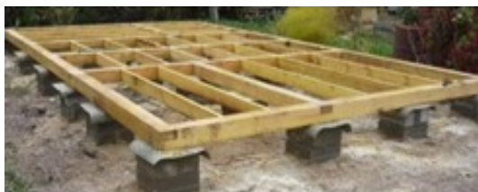
Пример столбчатого фундамента
