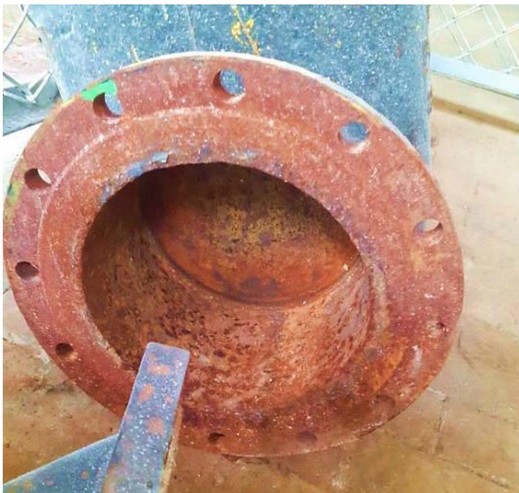
Рисунок 1 – Коррозия стыка задвижек
