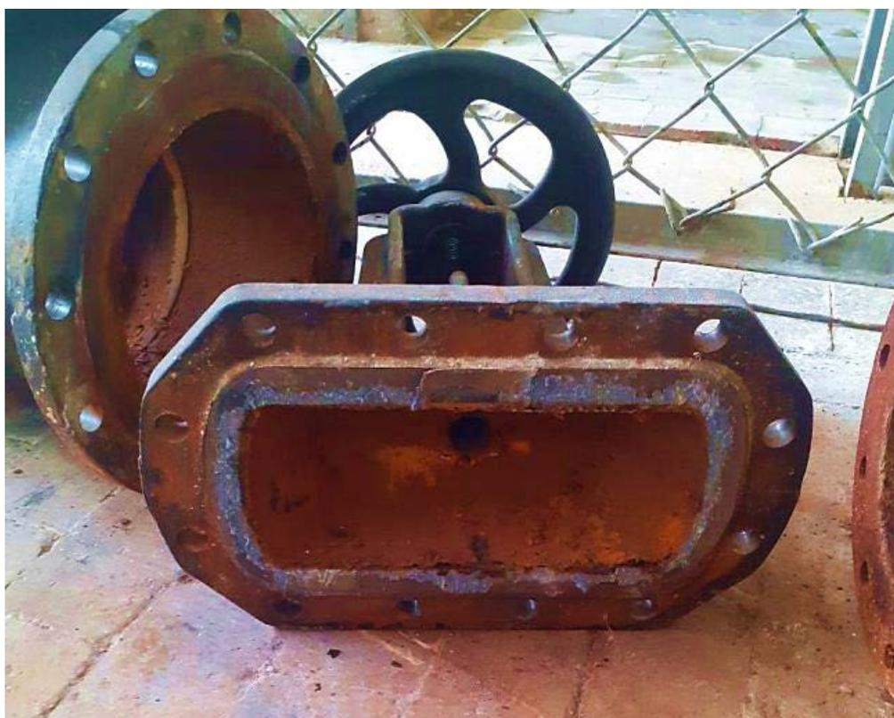
Рисунок 2 – Коррозия запорной арматуры
