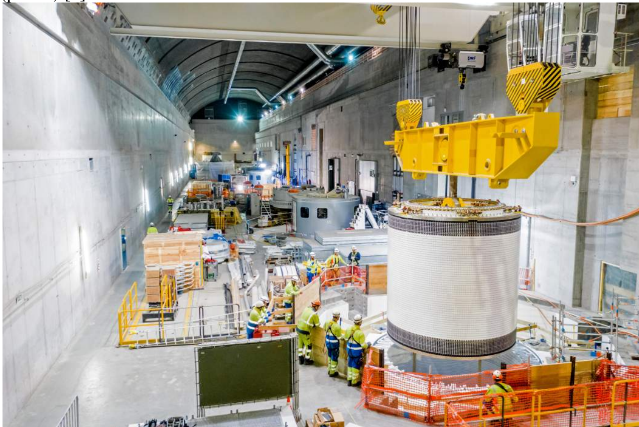
Рисунок 2 – Строительство машинного отделения электростанции Nant de Drance [2]
