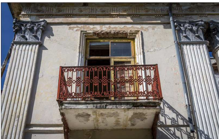
Рисунок 8. – Усадебный комплекс Уместовских, д. Жемыславль (1870 г.). Фрагмент оконного проема и балкона
