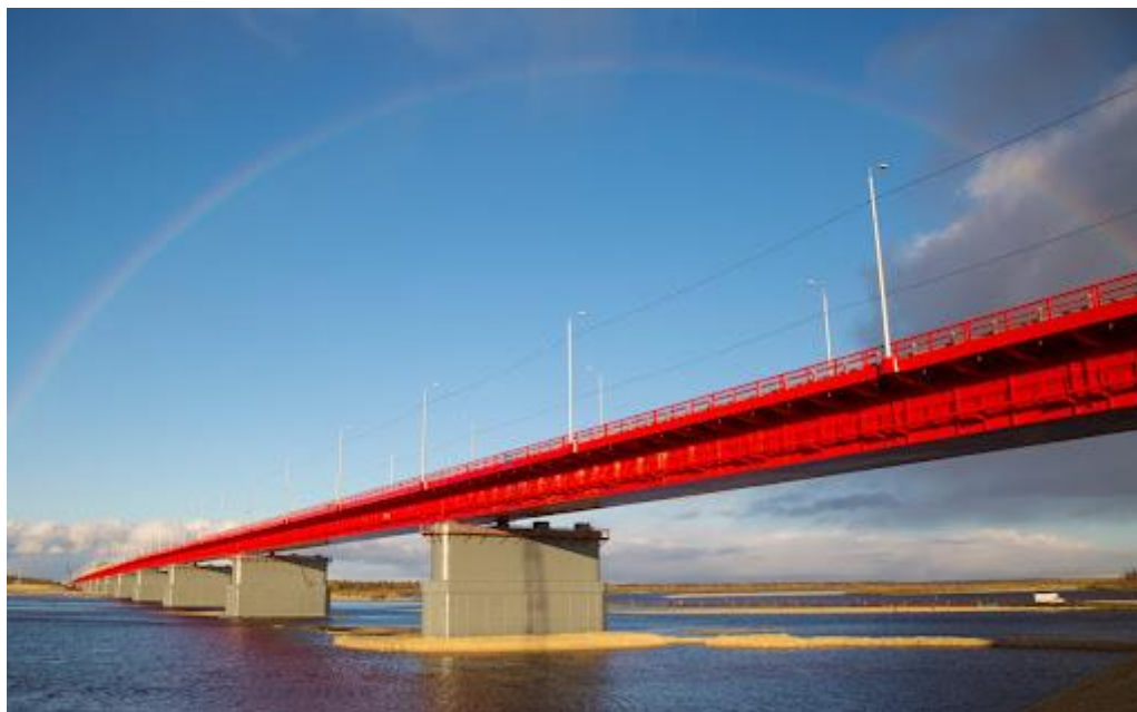
Рисунок 1 – Автомобильно-железнодорожный мост через р. Надым
