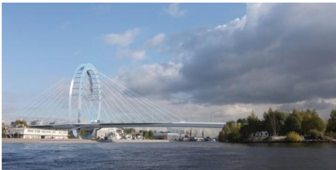
Рисунок 1 – Мост через остров Серный в Санкт-Петербурге
