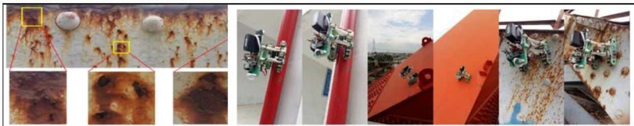
Рисунок 2 – Выполнение восстановительных работ
