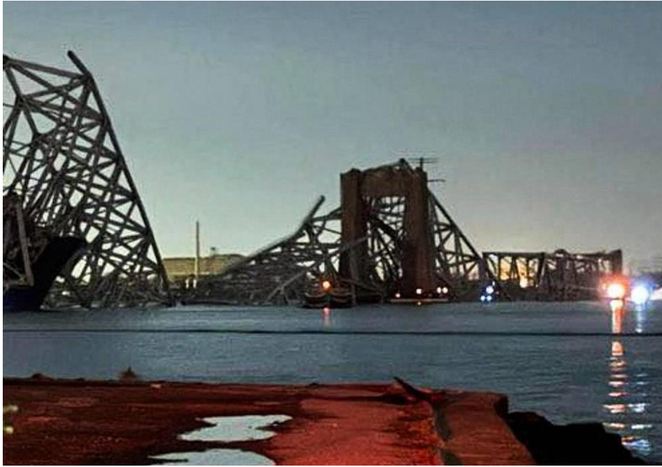
Рисунок 2 – Последствие обрушения моста
