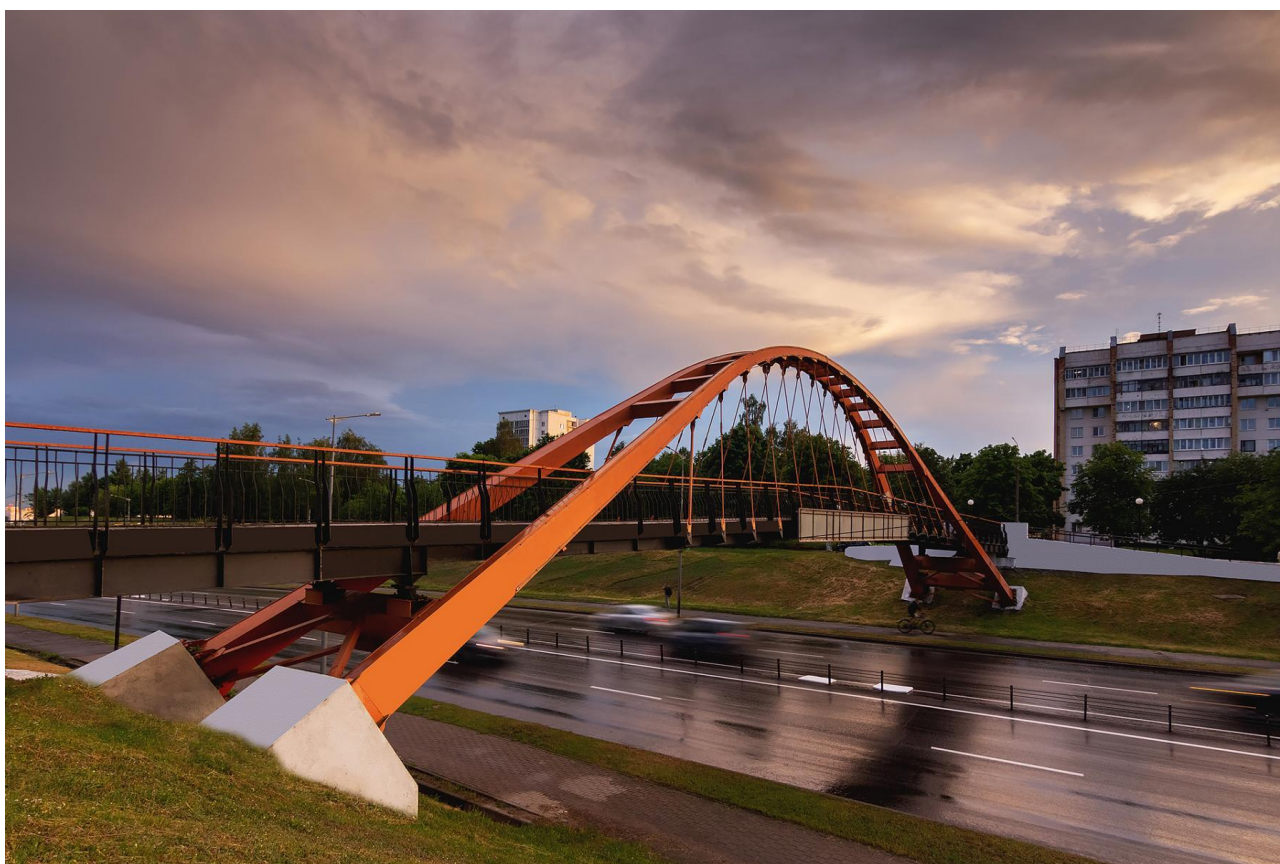
Рисунок 1 – Металлический мост по ул. Королева, г. Минск
