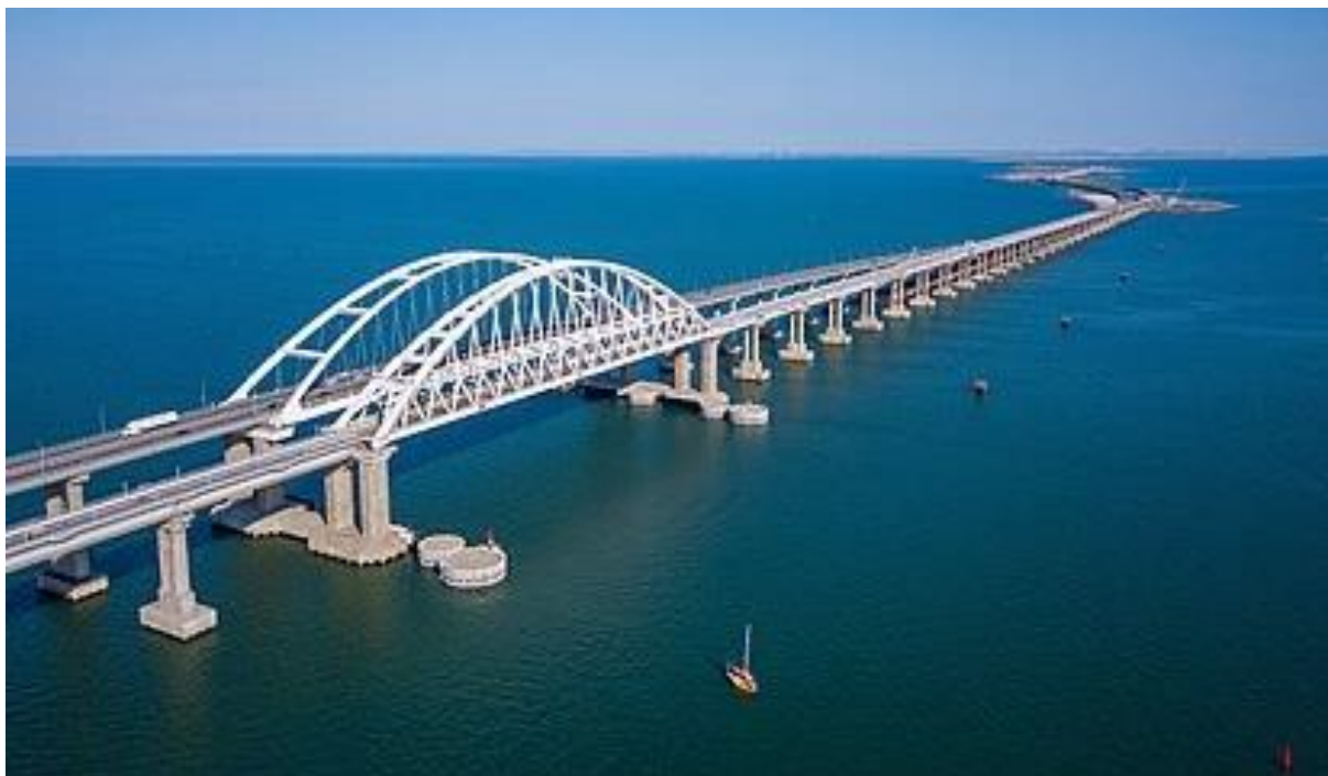
Рисунок 1 – Общий вид Крымского моста
