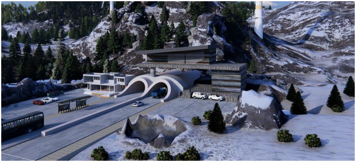
Рисунок 3 – Общий вид сооружения
