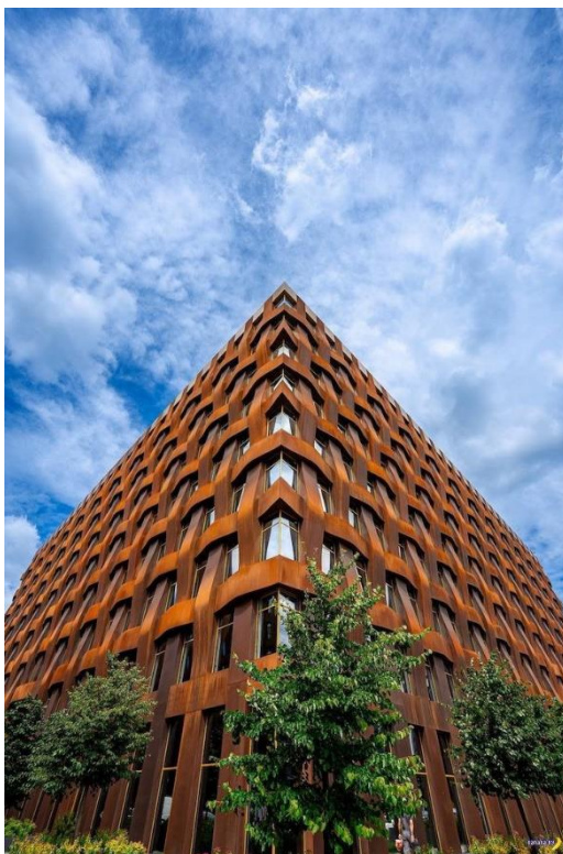
Рисунок 2 – фасад БЦ «Феррум» в Санкт-Петербурге, из кортен-стали
