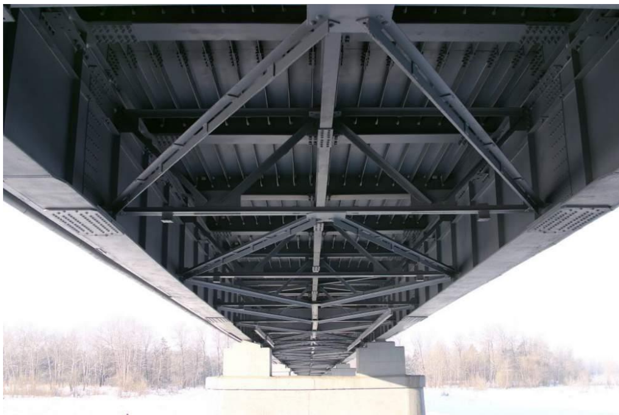
Рисунок 1 – Металлические пролетные строения
