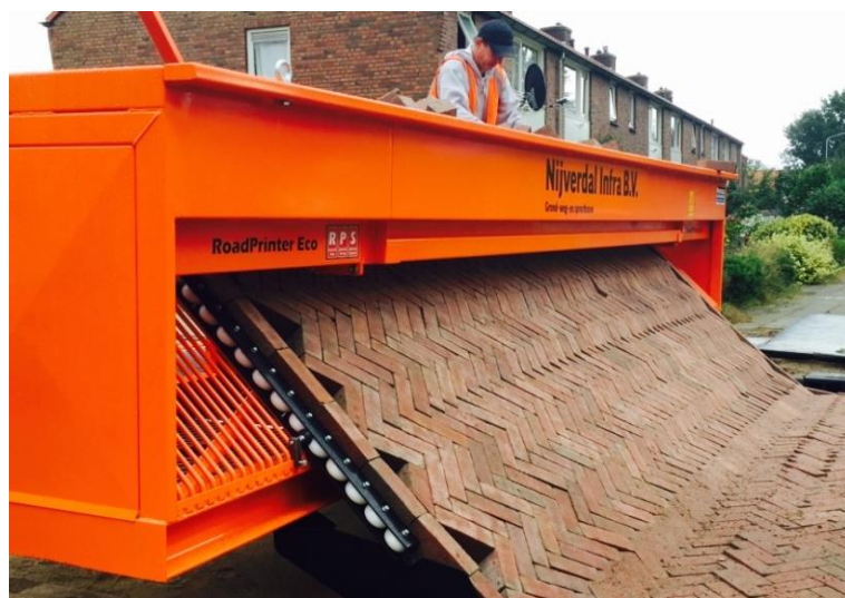
Рис. 1. Укладка тротуарного покрытия с помощью RoadPrinter ECO
