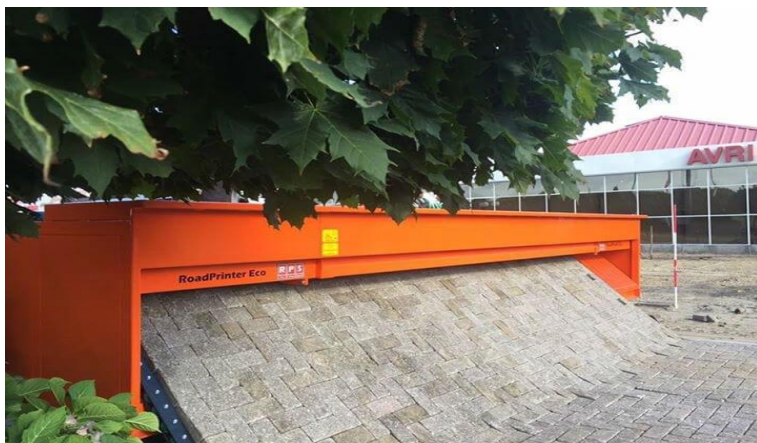
Рис. 2. Укладка тротуарного покрытия из кирпича бывшего в употреблении
