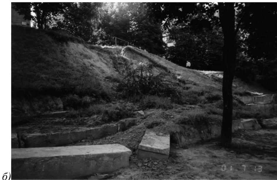
**Рис. 20** Образование промоин на откосе при струйчатой эрозии (а) и оврага на склоне за подпорной стеной на ул. Жудро в Минске (б) при нарушении одерновки
