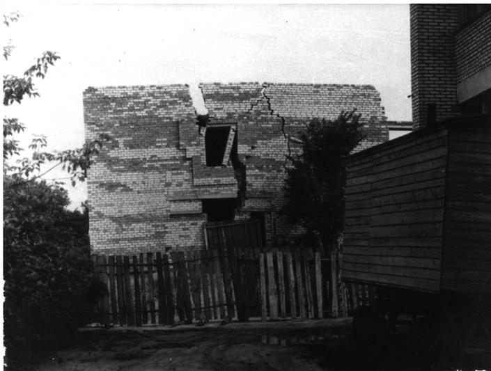
**Рис. 37.** Разрушение здания «Беларусбанка» в г. Шарковщина на склоне возле реки вследствие оползня, активизировавшегося при динамических воздействиях от забивки свай и разжижении ила в их основании
