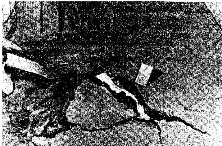
Рис. 13. Разрушение асфальтового покрытия растущими грибами
