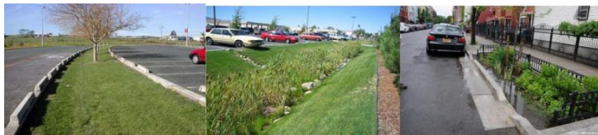
Рис.2. Применение биофильтрационного склона, биодренажного канала, дождевого сада [7]
