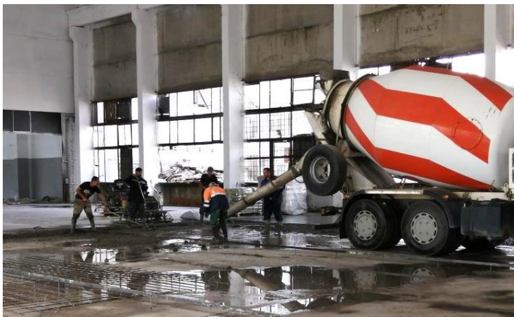
Рисунок 5.8 – Укладка смеси фибробетона многоуровневого армирования
