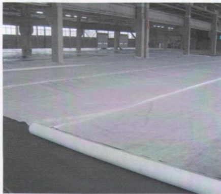
Рисунок 4.13 – Уложенный геотекстиль на поверхность бетона
