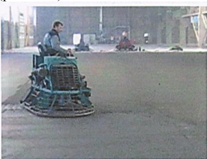
Рисунок 4.11 – Затирка поверхности пола бетоноотделочной машиной: а – затирка поверхности пола двухроторной бетоноотделочной машиной; б – затирка поверхности пола однороторной бетоноотделочной машиной
