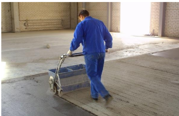
Рисунок 4.9 – Рассыпка топпинга тележкой
