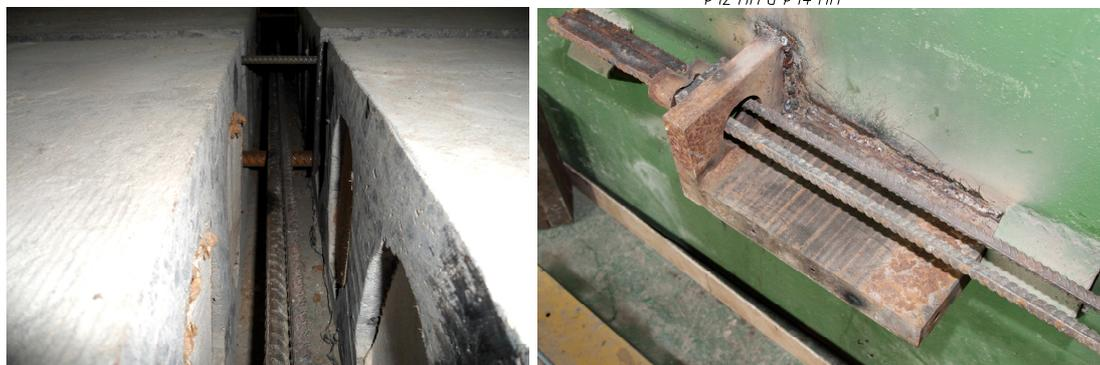
Рисунок 2 – Размещения продольных связей в диске перекрытия и их закрепление на опорах
