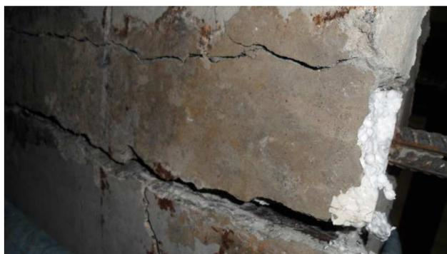
**Рисунок 7** – Отрыв бокового ребра на третьей стадии работы диска перекрытия. Полное выделение балки поперечного направления
