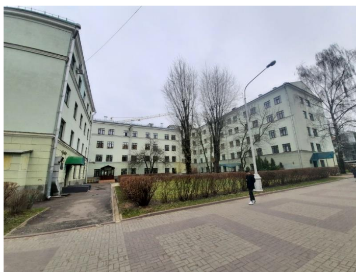
Рисунок 2 – Фасад задней части здания учебного корпуса №18 БНТУ
