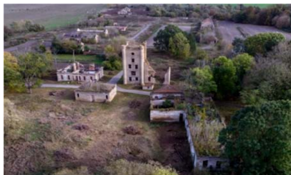
Рис. 6. Производственные строения имения Ястржембских, Борисовщина
