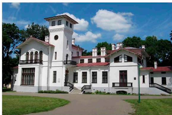
Рис. V. Жилое здание усадьбы Швыковских, Пружаны
