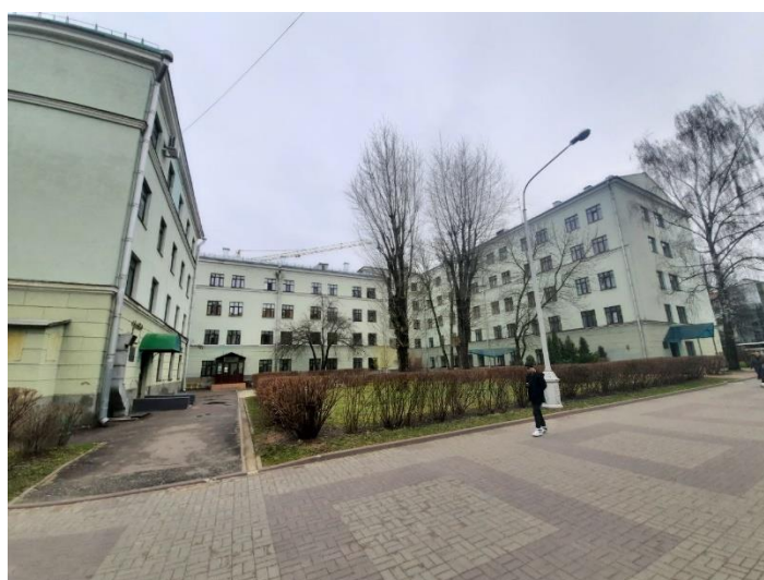
Рисунок 2 – Фасад задней части здания учебного корпуса №18 БНТУ
