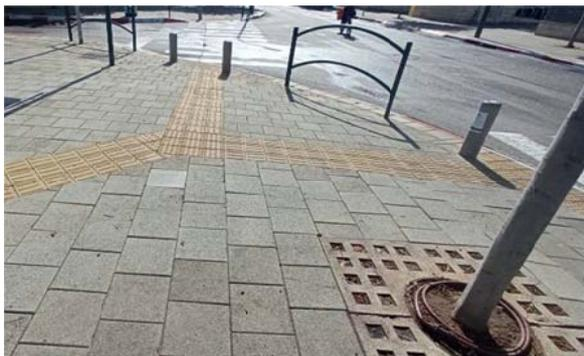
Рис. 7. Тактильное покрытие из направляющих и предупреждающих плиток
