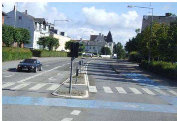
Рис. 4. Наземный регулируемый пешеходный переход с островком безопасности и выделенной полосой велодвижения в г. Торунь
