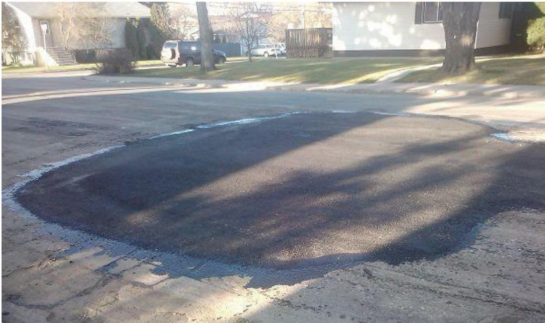
Рисунок 2 – Ремонт выбоины с использованием горячей асфальтобетонной смеси
