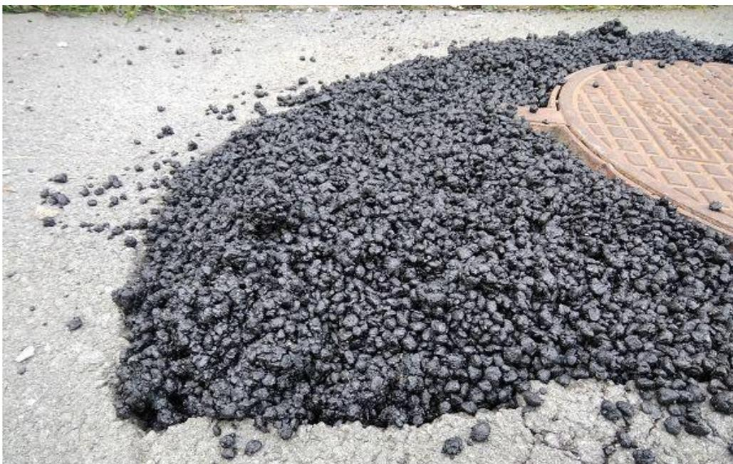
Рисунок 1 – Ремонт выбоины с использованием холодной асфальтобетонной смеси
