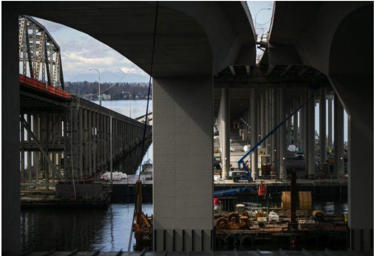
Рисунок 2 – Вид на понтонный мост снизу
