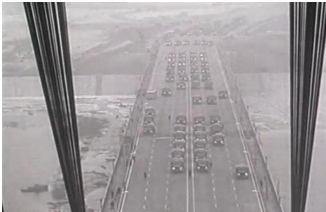
Рисунок 3 – испытание Северного моста
