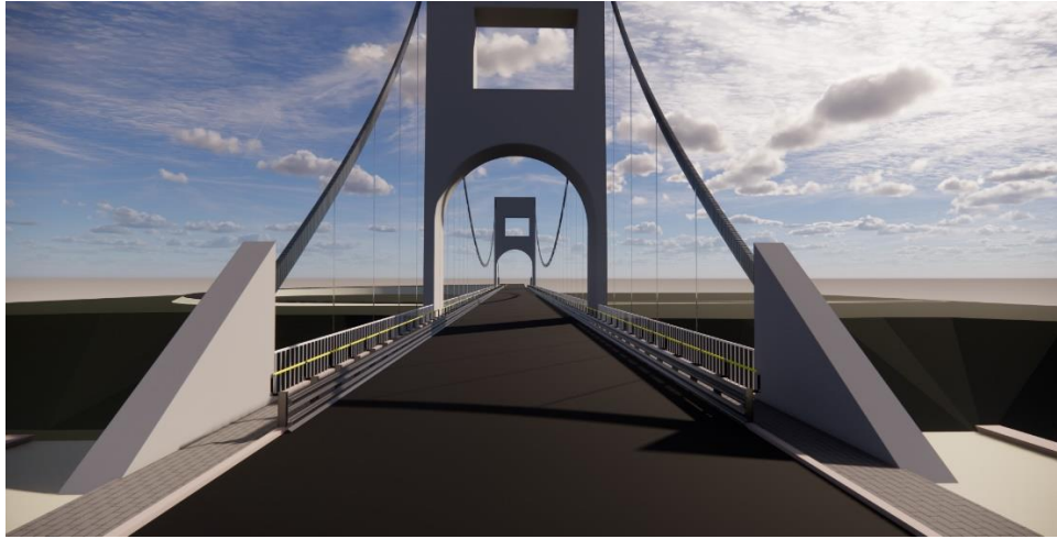
Рисунок 5 – Пилон висячего моста
