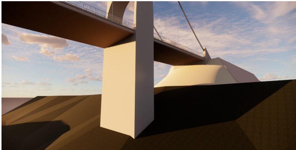
Рисунок 7 – Опора висячего моста
