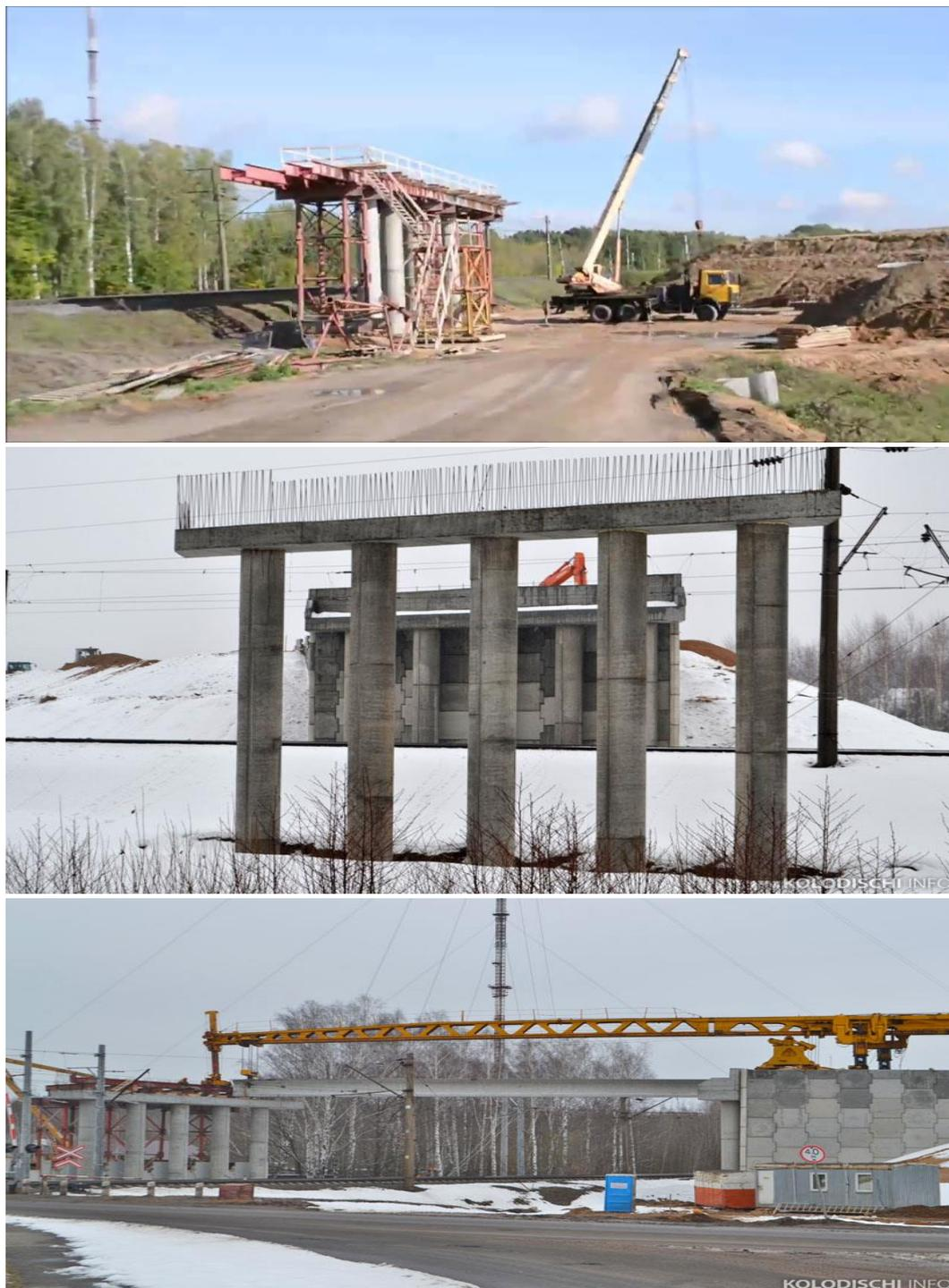
Рисунок 4 – Процесс строительства путепровода
