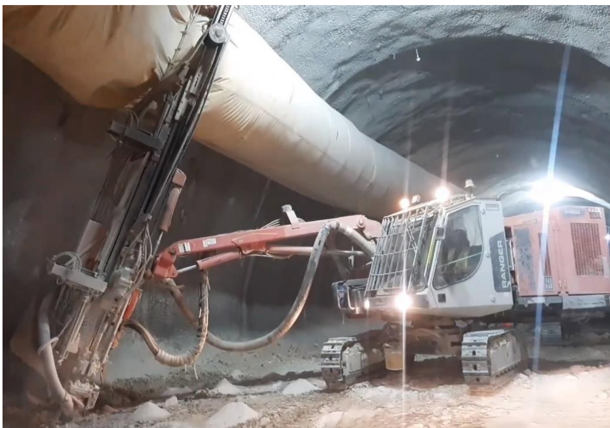
Рисунок 1 – Специализированная машина, предназначенная для бурения скважин в стеснённых условиях
