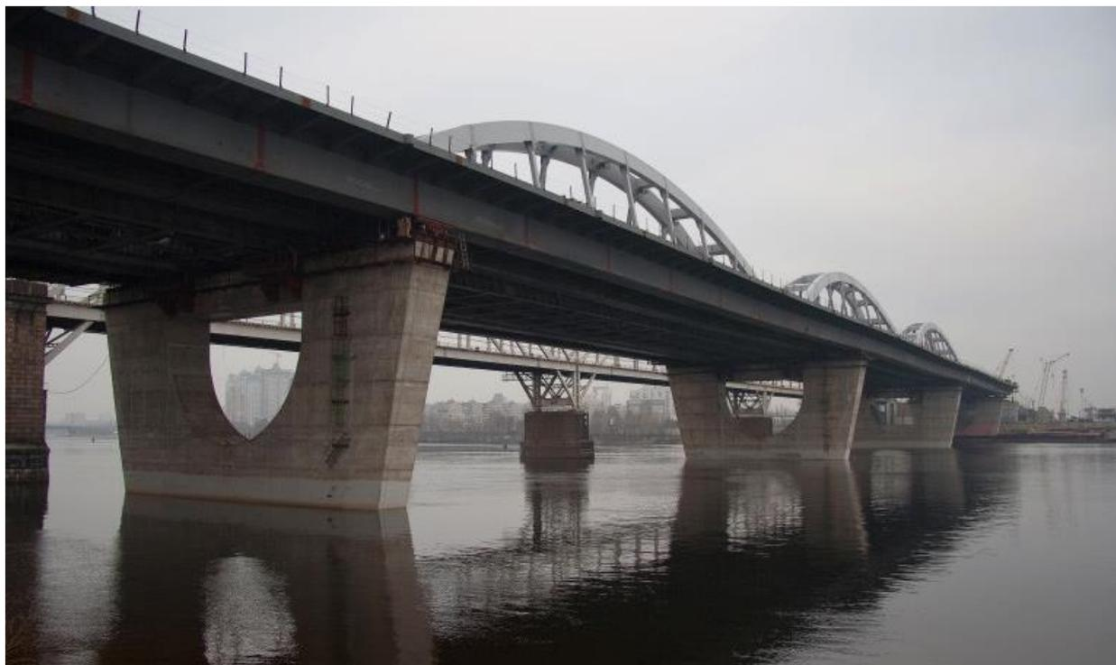
Рисунок 4 – Опоры Дарницкого железнодорожно-автомобильного моста
