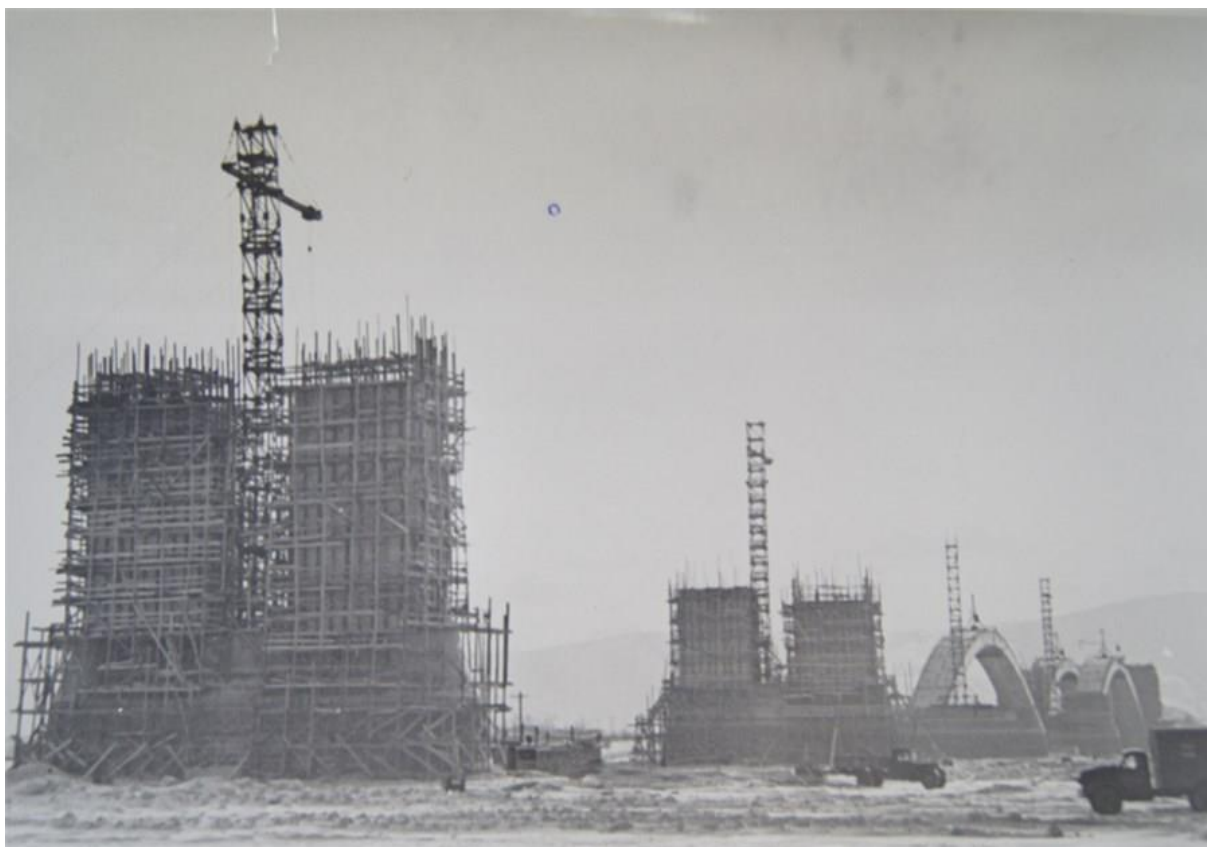
Рисунок 2 – Строительство Коммунального моста. Возведение опор
