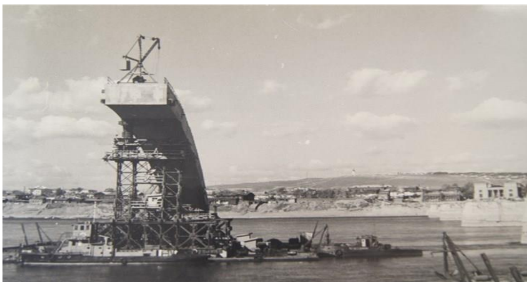
Рисунок 3 – Строительство Коммунального моста. Возведение свода арки
