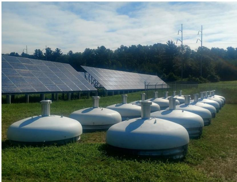
Рисунок 3 - Солнечная электростанция, использующая маховик
