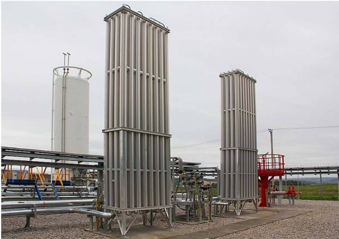
Рисунок 1 – Атмосферные испарители, используемые на нефтяных месторождениях [1]
