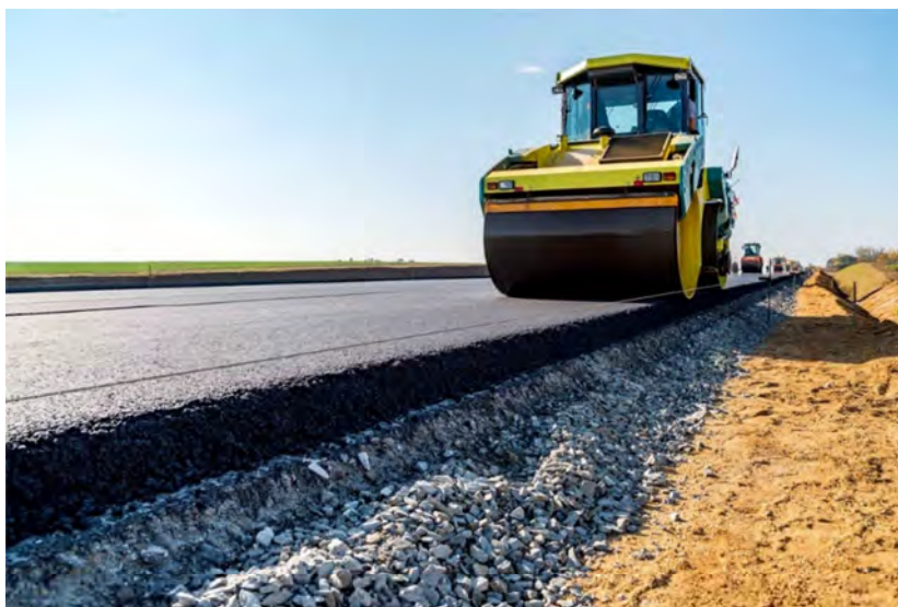
Рис. 6.6. Уплотнение асфальтобетонной смеси
