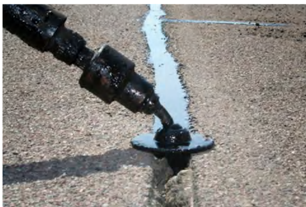
Рис. 7.34. Пример герметизации трещины асфальтобетонного покрытия
