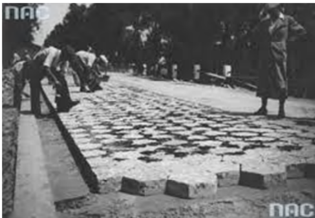
Рис. 2.16. Строительство дороги Пинск–Брест
