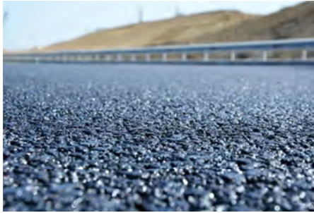
Рис. 7.21. Вид покрытия «Тонфриз» после укладки
