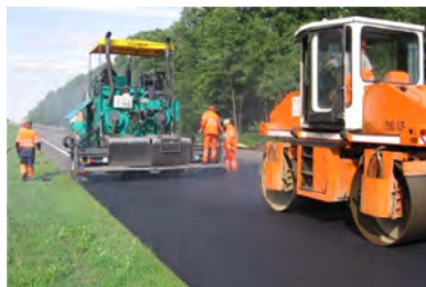
Рис. 7.14. Укладка слоя покрытия из асфальтобетонной смеси: a – выгрузка и распределение смеси асфальтоукладчиком; б – уплотнение смеси катками
