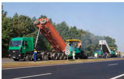
Рис. 7.14. Укладка слоя покрытия из асфальтобетонной смеси: a – выгрузка и распределение смеси асфальтоукладчиком; б – уплотнение смеси катками
