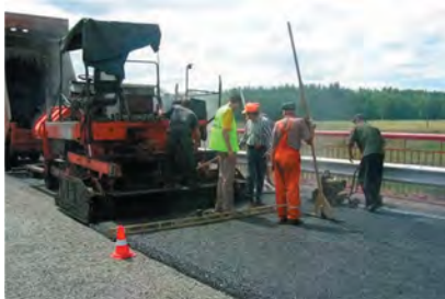
Рис. 7.25. Устройство защитного слоя по мембранной технологии: а – устройство мембраны из модифицированного битума; б – укладка технологического слоя из щебня по мембране; в – укладка защитного слоя из асфальтобетона
