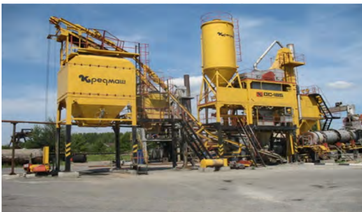
Рис. 7.15. Завод по приготовлению асфальтобетонных смесей
