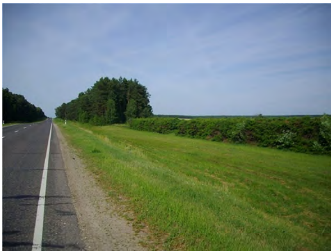
Рис. 7.26. Постоянные снегозащитные сооружения «живая» изгородь из елей и лесополоса
