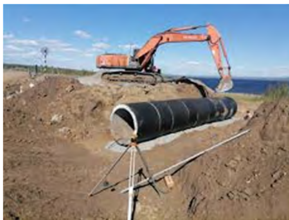
Рис. 7.4. Устройство водопропускных труб
