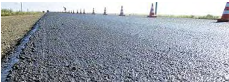
Рис. 7.23. Вид уложенного защитного слоя из холодных литых асфальтобетонных смесей
