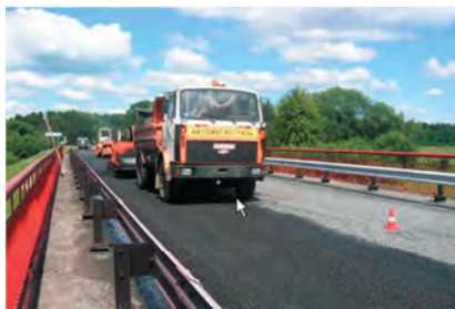
Рис. 7.25. Устройство защитного слоя по мембранной технологии: а – устройство мембраны из модифицированного битума; б – укладка технологического слоя из щебня по мембране; в – укладка защитного слоя из асфальтобетона
