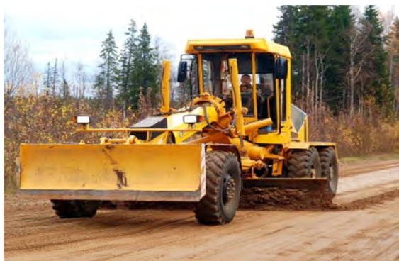
Рис. 7.31. Профилировка гравийного покрытия
