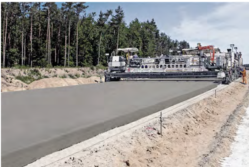
Рис. 6.7. Укладка цементобетонной смеси
