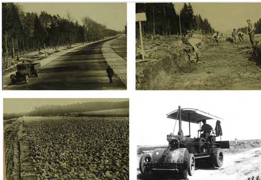
Рис. 2.15. Строительство дороги Минск–Москва
