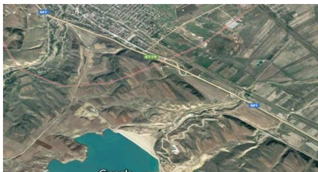
Рисунок 1 – Плотина Тахтакорпюнского водохранилища
