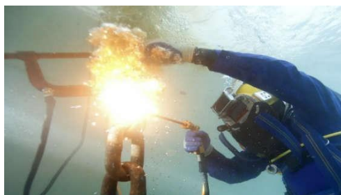
Рисунок 1 - Сварка под водой
