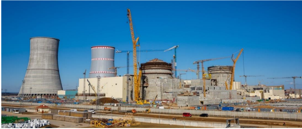
Рисунок – Этап строительства первого и второго энергоблоков АЭС в г. Островец
