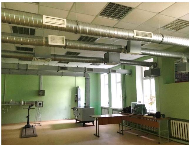
Рис. 9.1. Воздухораспределители на модели приточной вентиляционной системы учебной лаборатории
