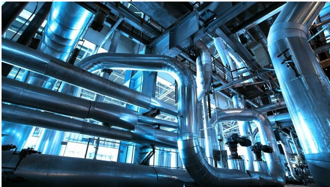
Рисунок 1 – Общий вид технологических трубопроводов
