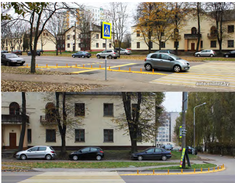
Рис. 6.44. Сужение проезжей части в зоне нерегулируемого пешеходного перехода (ул. Казинца, г. Минск)
