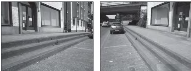
Рис. 10.16. Варианты устройства сопряжения тротуара и проезжей части
