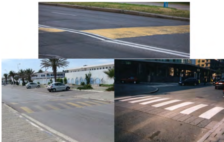
Рис. 6.56. Пример устройства искусственной неровности (г. Минск)
