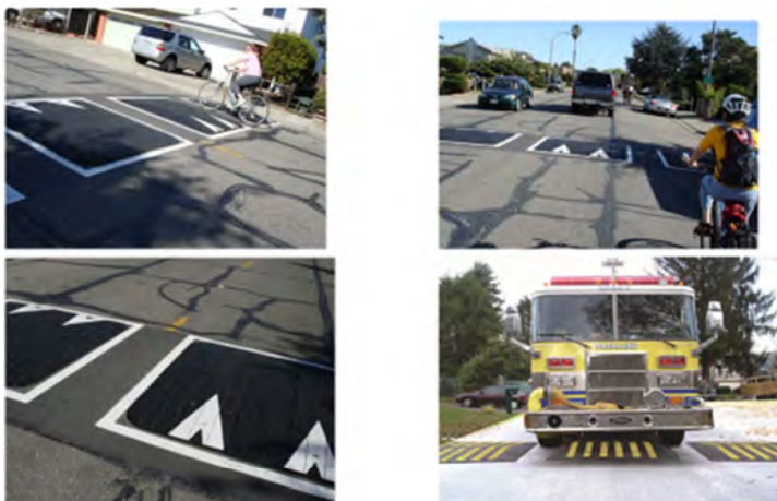
Рис. 6.16. Пример устройства «подушки» скорости
