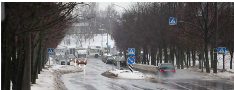
Рис. 6.54. Устройство зигзага островком безопасности и сужением проезжей части с помощью резервных полос для стоянок транспорта (ул. Некрасова, д. 122, г. Минск)
