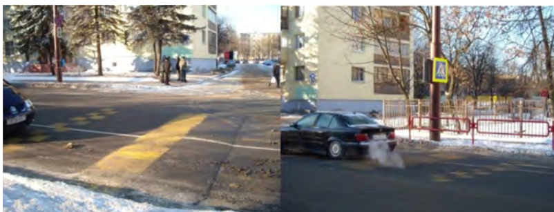
Рис. 6.57. Искусственная неровность на подходе к пешеходному переходу по ул. Куйбышева, д. 57, г. Минск
