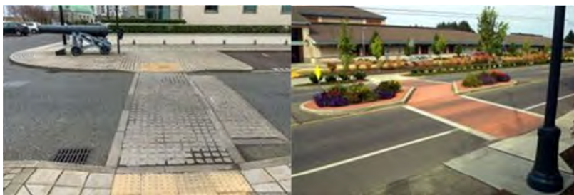
Рис. 6.30. Пример реализации предупреждающего обустройства
