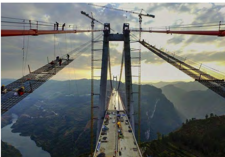
Рисунок 4 – использование дронов в строительстве мостов
