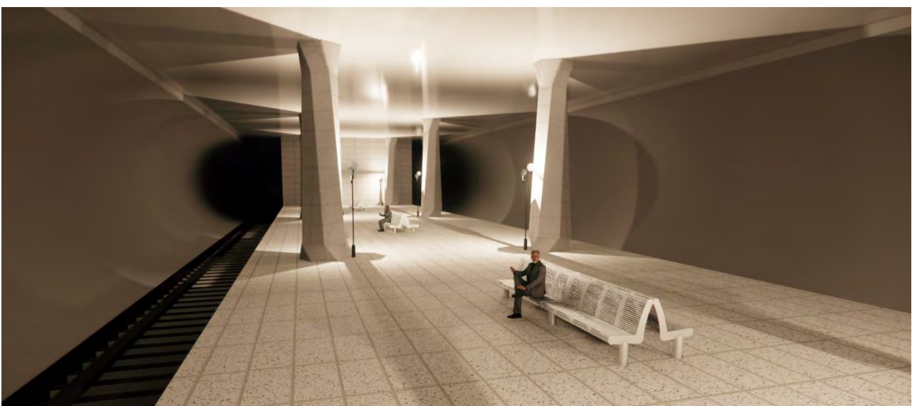
Рисунок 4 – Внешний вид станции метро
