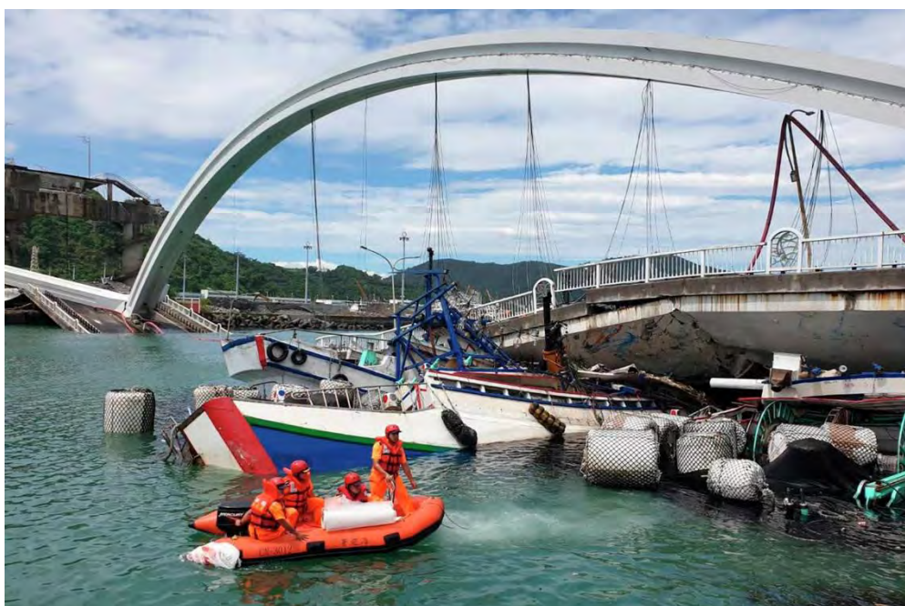
Рисунок 1 – Обрушение моста в Тайване в 2019 году
