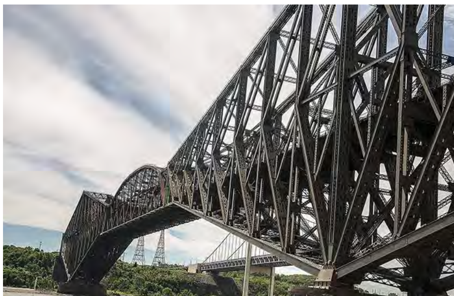
Рисунок 3 – Квебекский мост, Канада (наше время) (Источник – https://2drive.ru/krupnye-obrusheniya-mostov/ )
