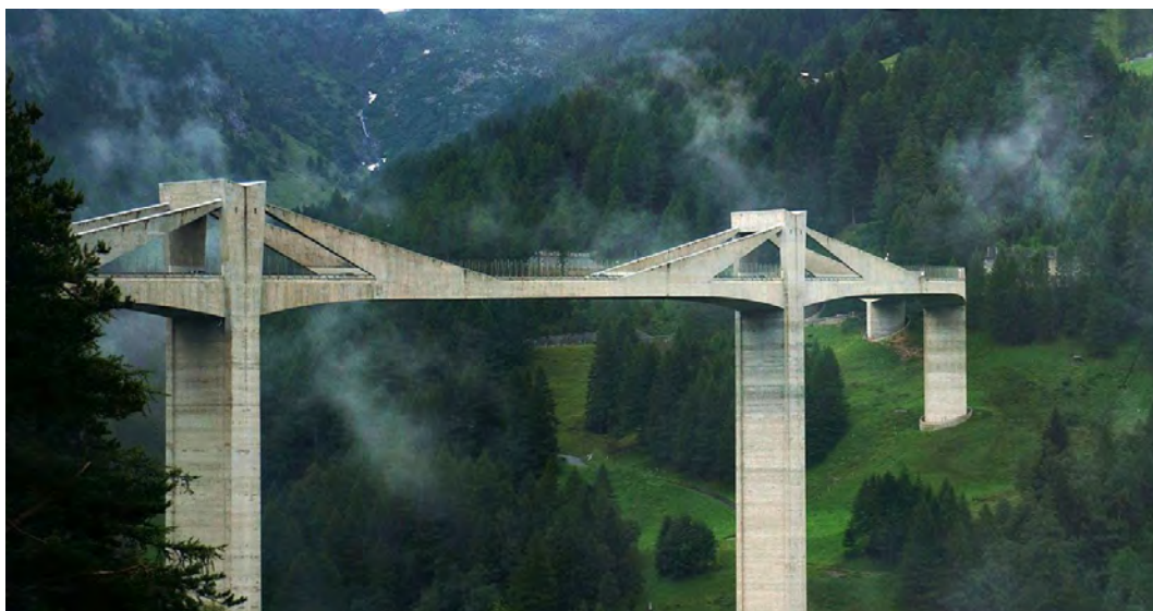
Рисунок 3 – мост Гантер. Источник: 1280px-Ganterbrücke_(14829574022).jpg (1280×670) (wikimedia.org)
