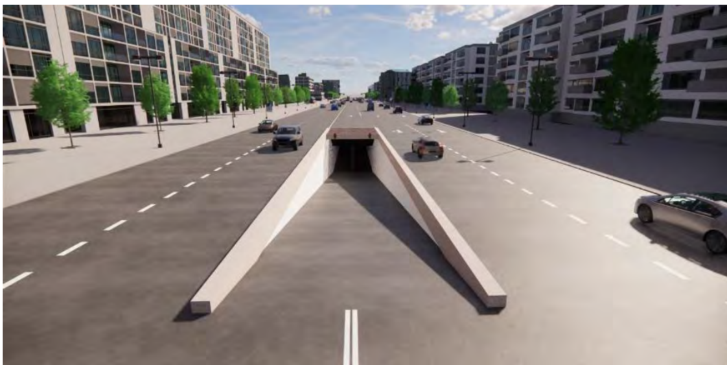
Рисунок 6 – Въезд в автомобильный тоннель
