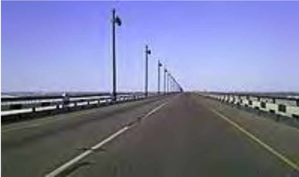
Рисунок 3 – Автомобильная часть моста
