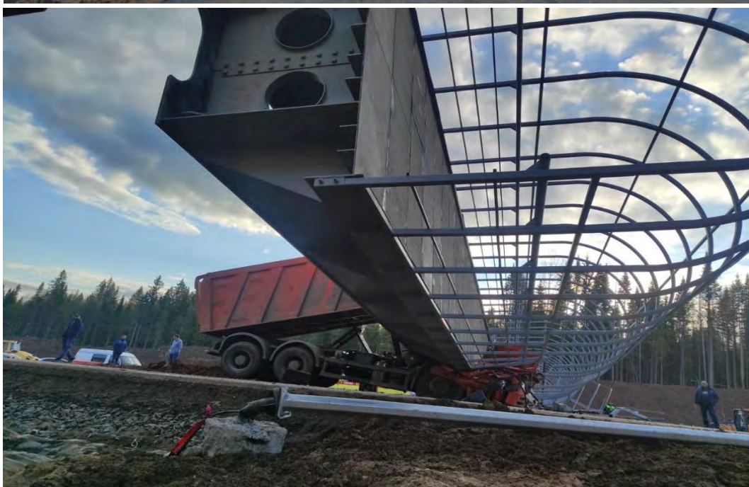
Рисунок 8 и 9 – Обрушение пешеходного моста на 50-м километре федеральной трассы Р-242 Пермь-Екатеринбург ( Источник – https://perm.bezformata.com/listnews/ekaterinburg-gruzovik-snyos-nadzemniy/105956015/ )
