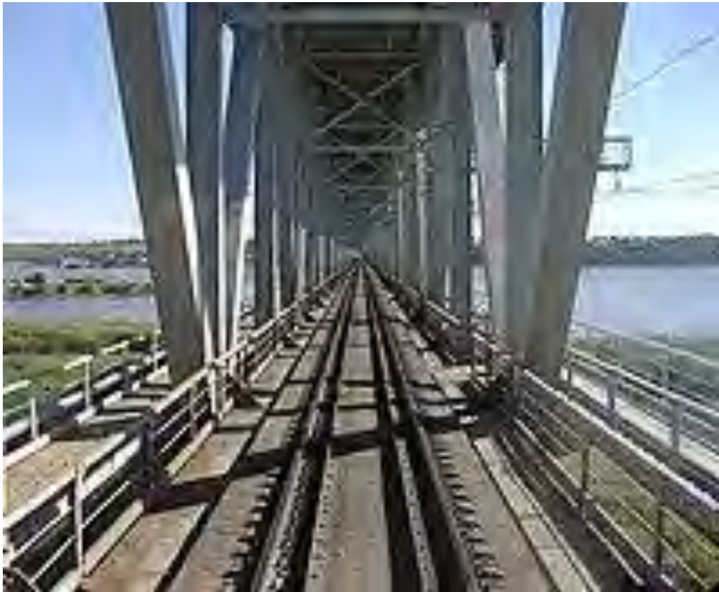
Рисунок 2 – Железнодорожная часть моста
