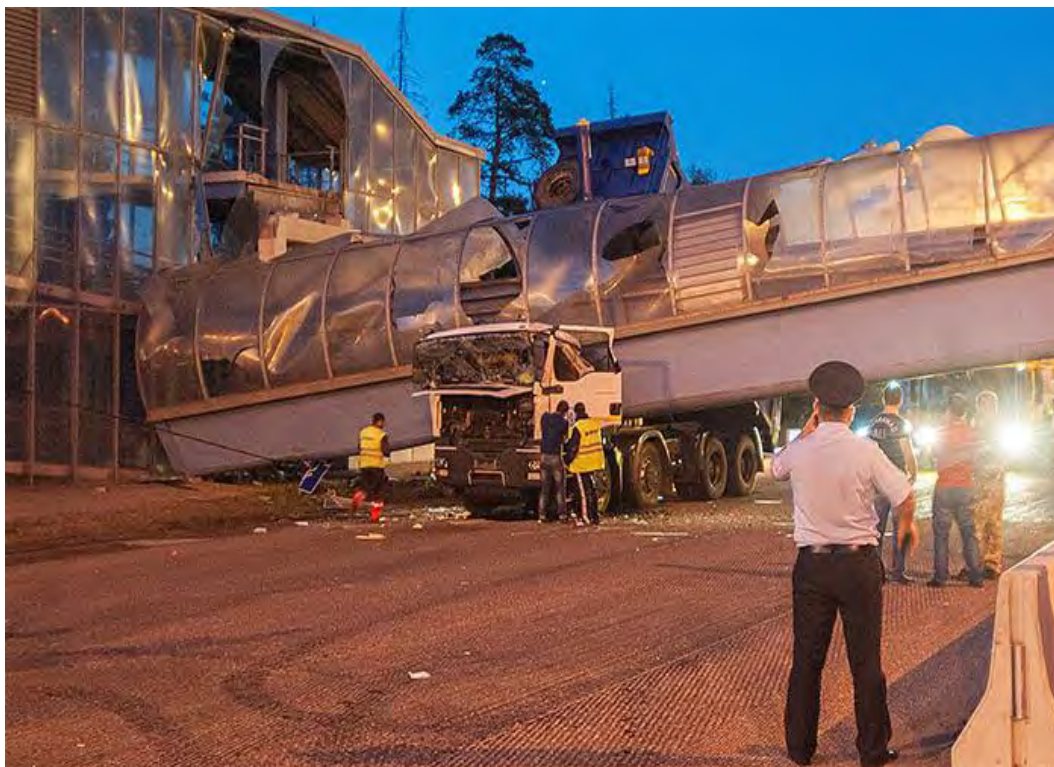
Рисунок 7 – Обрушение пешеходного моста на 49 км трассы М-10(источник – https://www.interfax.ru/photo/2835/30932 )
