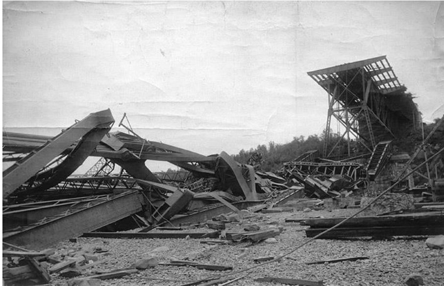
Рисунок 4 – Разрушенный Квебекский мост, Канада (Источник – https://2drive.ru/krupnye-obrusheniya-mostov/ )
