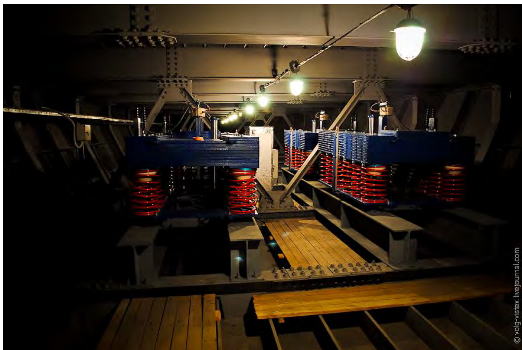
Рисунок 2 – Полуактивные демпферы массы ATMD-V-5200
