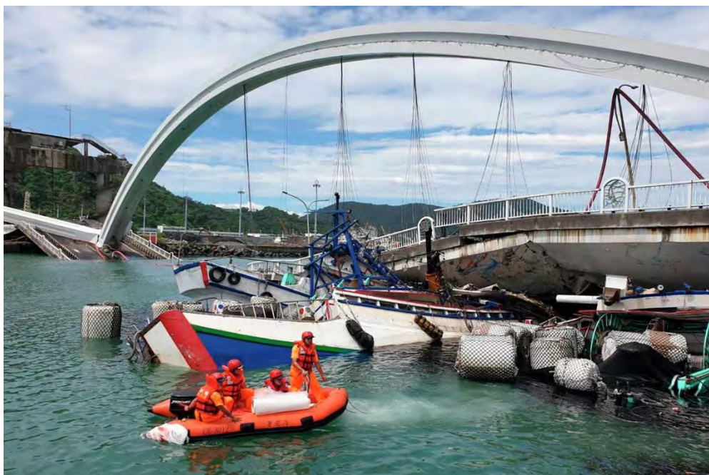
Рисунок 1 – Обрушение моста в Тайване в 2019 году
