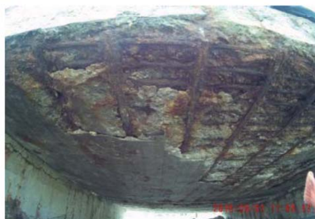
Рис. 4. Пролет пешеходного моста Холмского морского торгового порта
