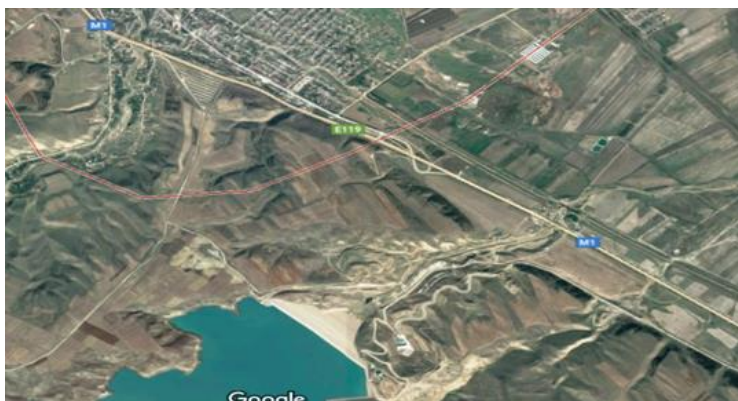
Рисунок 1 – Плотина Тахтакорпюнского водохранилища
