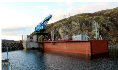
Рис. 3. Кислогубская приливная электростанция (ПЭС)
